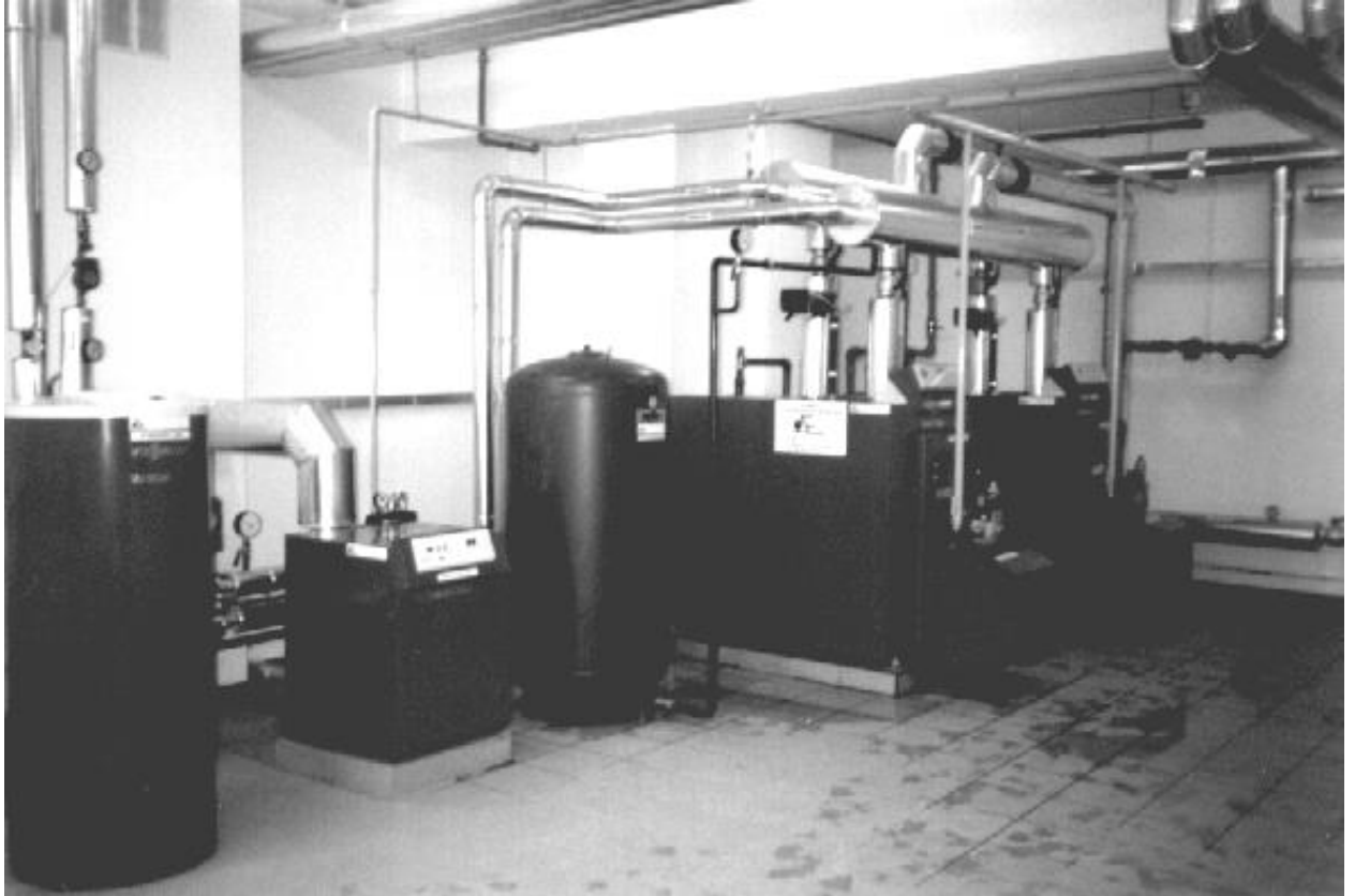
FOT.24. Kotłownia wodna /gaz/. Kotły niemieckiej firmy VISSMANN . (ZWU Grojec).
