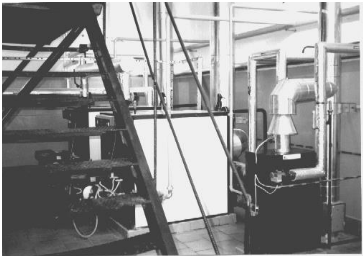
FOT.1. Kociołownia wodna C.O. i C.W.U. gaz/olej o mocy 280 kW. Kotływłoskiej firmy CARBOFUEL (Rejon Energetyczny Limanowa).
