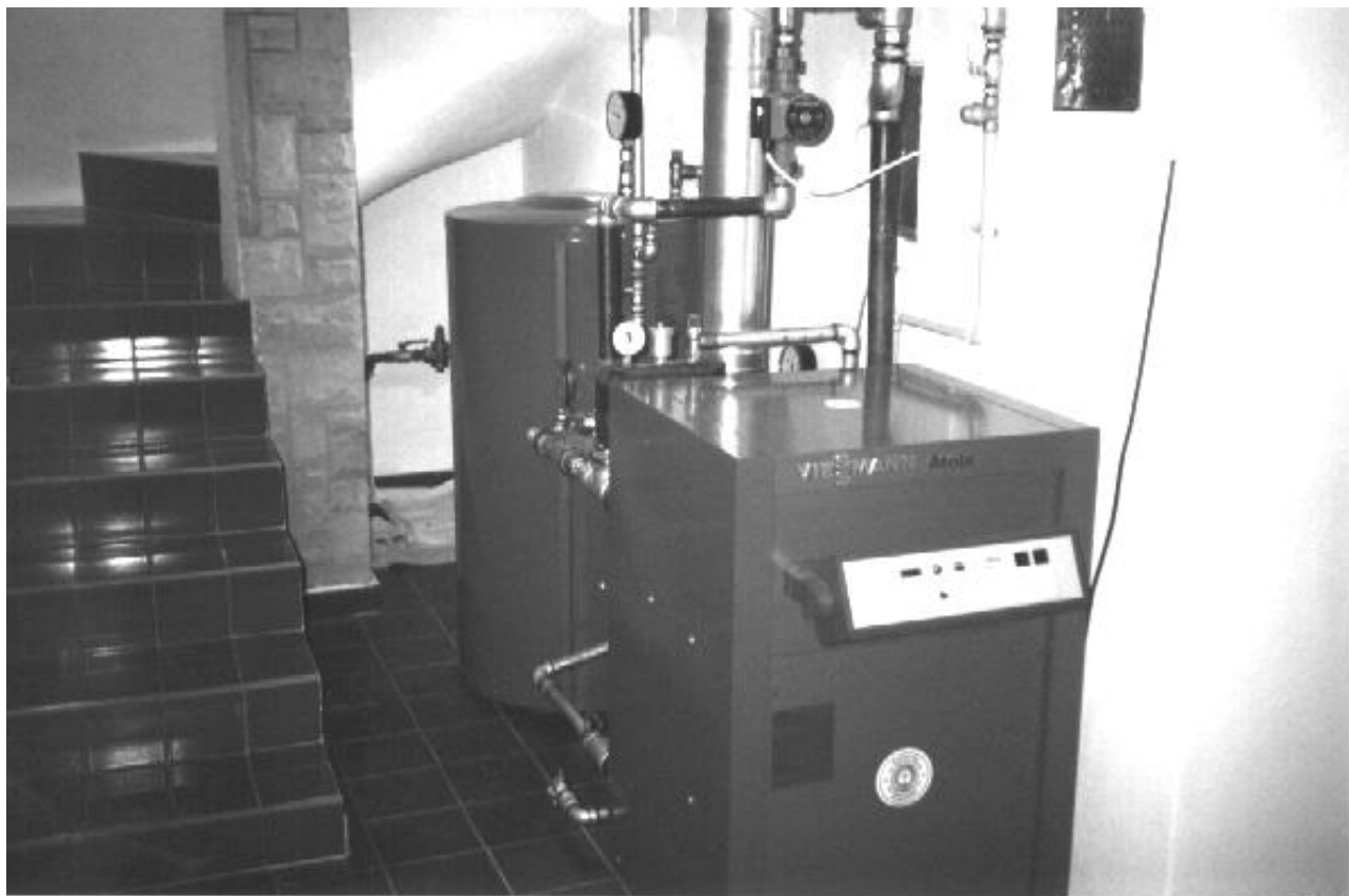
FOT.5. Kotłownia wodna gazowa o mocy 100 kW. (Kotłownia polskie FAKORA WKU Bochnia)
