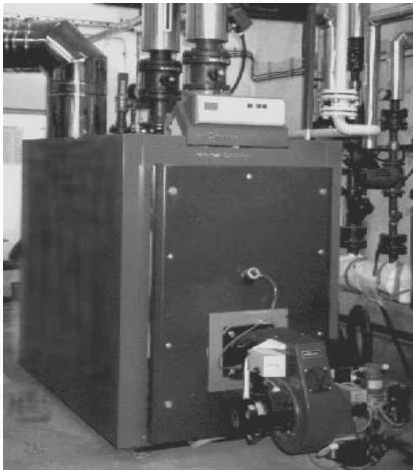
FOT.30. Kotłownia parowa gazowa, wyd. pary 2,6 t/h (Chłodnie Zgoda - Korczyna).
