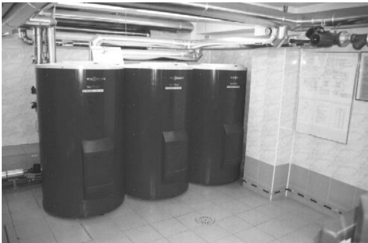
FOT.13. Kotłownia wodna olejowa o mocy 33 kW. Kocioł produkcji niemieckiej VISSMANN typu Vitola uniferral. (Inwestor prywatny)
