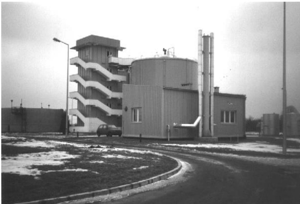
FOT.3. Kotłownia wodna gaz/biogaz o mocy 880 kW – widok ogólny budynku kotłowni. (Oczyszczalnia ścieków w Dębicy).
