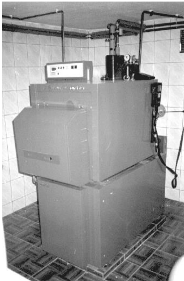
FOT.13. Kotłownia wodna olejowa o mocy 33 kW. Kocioł produkcji niemieckiej VISSMANN typu Vitola uniferral. (Inwestor prywatny)
